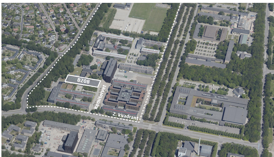
B208 ligger i 2. kvadrant på Lyngby Campus. Bygningen får en ny indgang til Kemitorvet, der er en central plads i området. Foto: DTU
