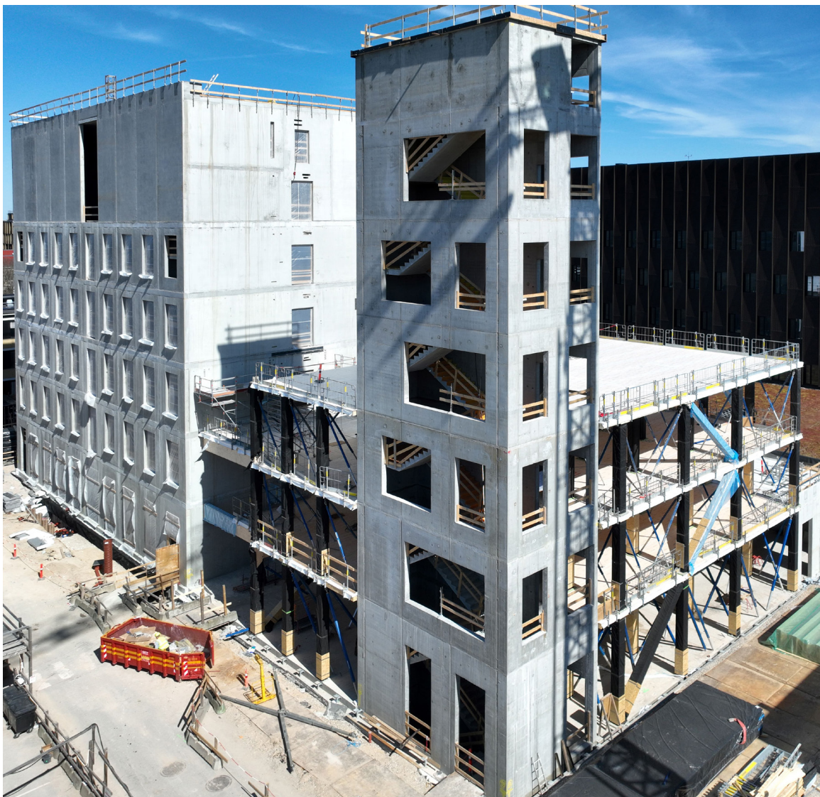
CLT og beton. Climate Challenge Laboratory bliver opført som en hybridløsning med en trækonstruktion og en betonkonstruktion. Foto: DTU
