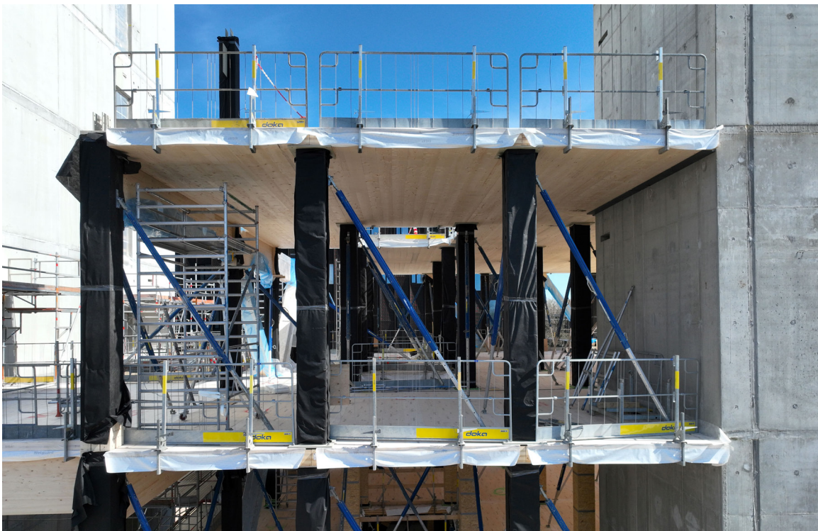
Træ og beton. På byggepladsen rejser trækonstruktionen sig etage for etage. Foto: DTU
