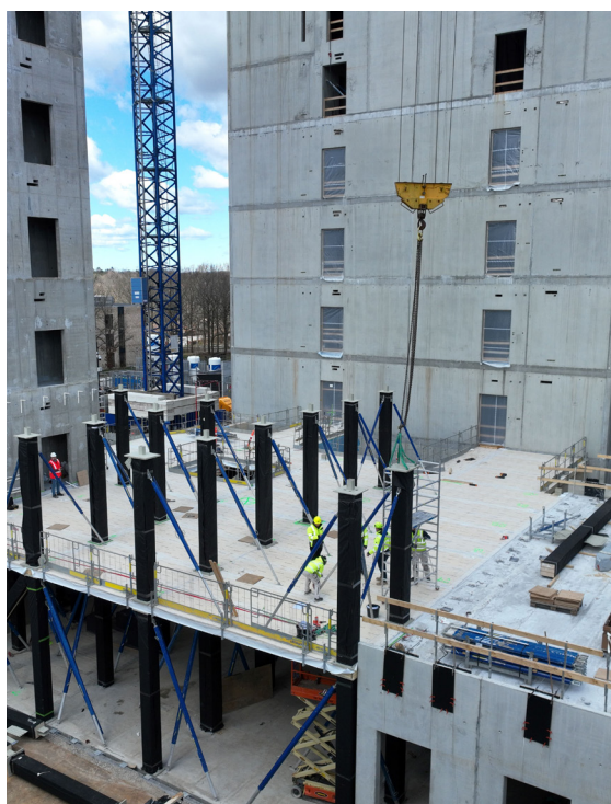
På pladsen. CLT Danmark producerer træ søjlerne og monterer beslagene på fabrik. CLT-elementerne bliver leveret på lastbiler i den rækkefølge de skal monteres på pladsen (billede tv). MT Højgaard hejser dem af direkte fra vognen i en særlig løfteanordning (billede th.) udviklet til at sikre elementerne sænkes lige ned og er nemme af afmontere for en tømrer. Foto: DTU
